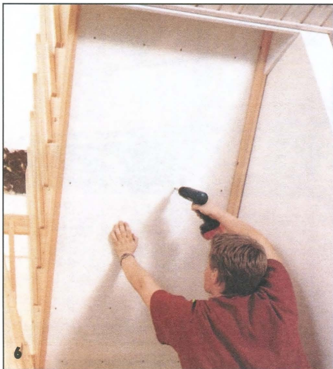
Детали обшивки крепили к обрешетке шурупами. Листы обшивки надо точно подогнать к проему, чтобы по краям не было заметных зазоров.
